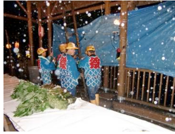
大雨でシートを貼る
