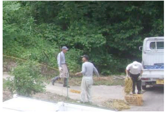
安全柵の設置
